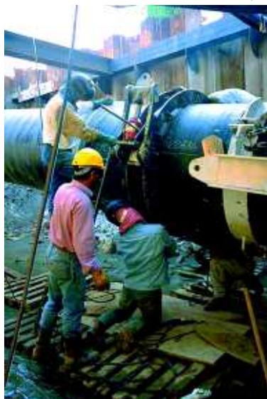
Varo condotta. Accoppiamento e saldatura
