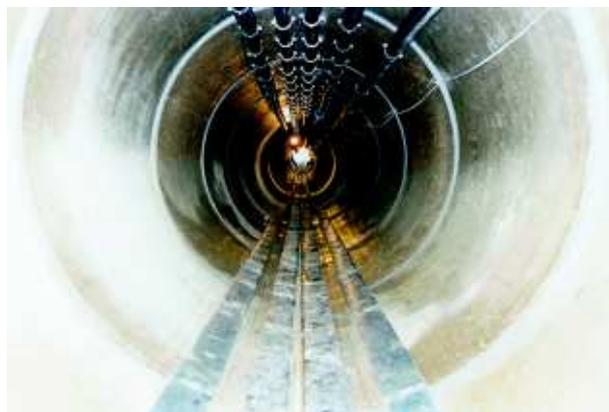
L'area dove sarebbero passati i collari di scorrimento. Le bande di scorrimento sono state fissate l'una accanto all'altra nella soletta del tunnel mediante viti. Le teste delle viti sono state sprofondate di ca. 8 mm nelle bande di scorrimento e ben fissate su ogni banda. I bordi dei giunti di collegamento delle bande di scorrimento sono stati smussati per creare un invito al passaggio dei collari.
