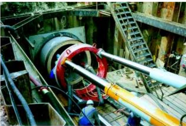
▲ Fiume Adige. Stazione di spinta: completata la spinta di un elemento tubolare in c.a.; carrello in fase di arretramento.
