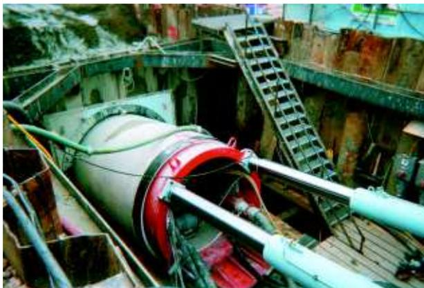
▲ Fiume Adige. Stazione di spinta: Fase di spinta di un elemento tubolare in c.a.
