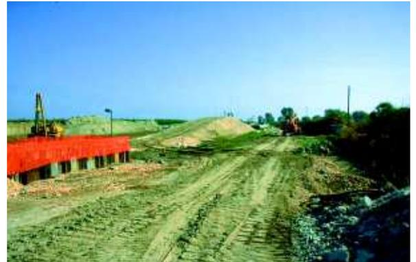
▼ Fiume Po. Preparazione della pista di varo con sbancamento
