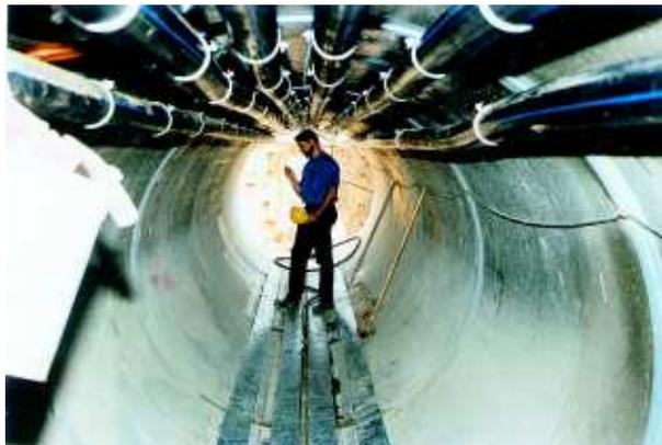
Il Direttore Lavori Ing. Stefano Zannier, della Società Enereco, all'interno del tunnel pronto per il varo della condotta. Si notano i binari di scorrimento sul fondo ed i tubi per l'intasamento in volta
