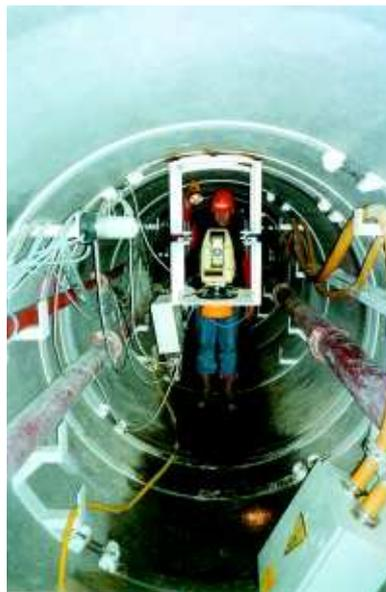
▲ Interno del tunnel. In primo piano strumentazione laser per il controllo direzionale
