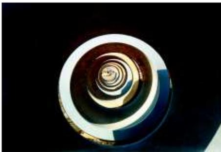
▲ Tubi in c.a. (2000x2500), completi di tre valvole di iniezione e tre guarnizioni di tenuta (due anteriori ed una posteriore). Nel particolare tavola in legno per la distribuzione dei carichi
