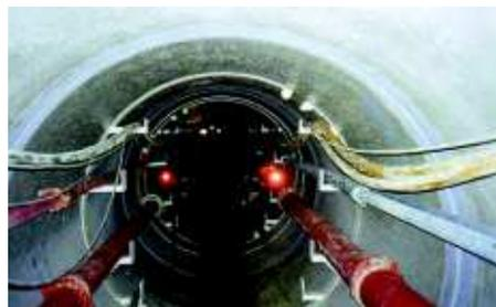
▲ Interno del tunnel. In primo piano si notano i riflessi dati dai prismi per il controllo direzionale laser
