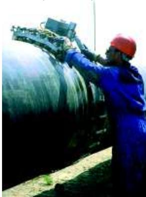
Fasciatura del giunto di saldatura
