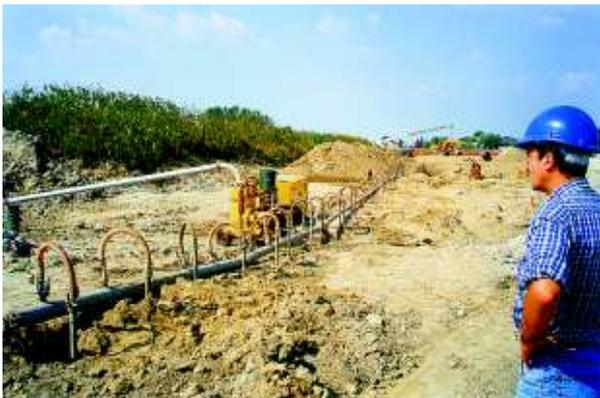
▲ Impianto Well Point durante l'esecuzione dello scavo in linea
