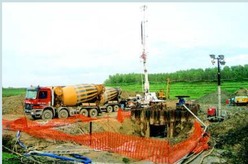
stabiliti e verificata ulteriormente la posizione di catenaria del tubo, ha dato il comando per cominciare l'operazione di traino del tronco. Durante tutta la fase di traino due operatori nel pozzo di spinta hanno provveduto ad ingrassare manualmente con Biogrease EP00/000 ogni collare distanziatore che scorreva all'interno del microtunnel.
