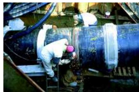
▲ Saldatura in manuale di un giunto
